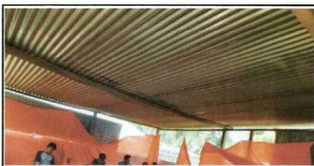
Foto 6: Cambio de entechado.
