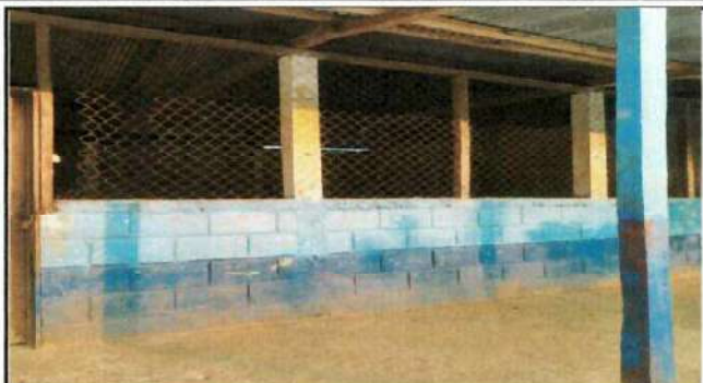
Foto 1: Ampliación de paredes frontal.
