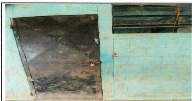
Foto 5: Instalación de chapas.
