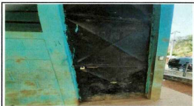
Foto 4: Sustitución de puerta.
