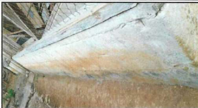
Foto 2: Ampliación de paredes parte de atrás.
